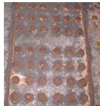
図4 ボルト頭部の腐食
