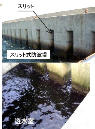
図1 スリット式防波堤
